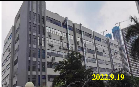
三期西面工业厂房
