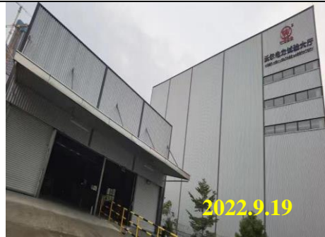
三期北面工业厂房
