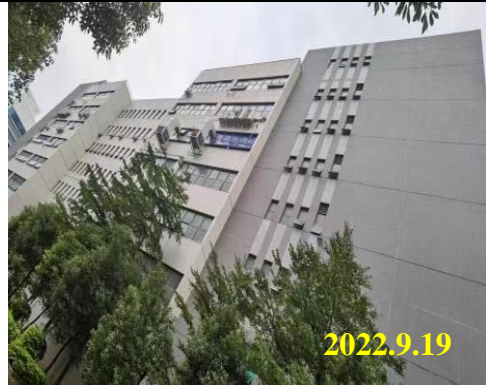
三期南面工业厂房
